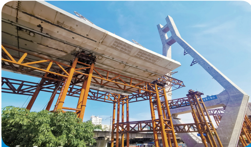
中建桥梁福建龙岩大桥钢箱梁 首次滑移过塔顺利完成
