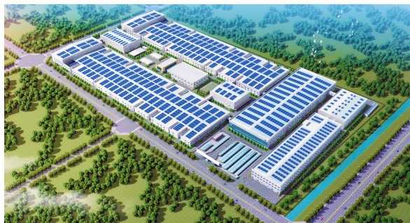
△ 江西上饶马鞍山新兴产业园，是江西省重点公投项目，为工程局深耕江西地区奠定良好基础。
