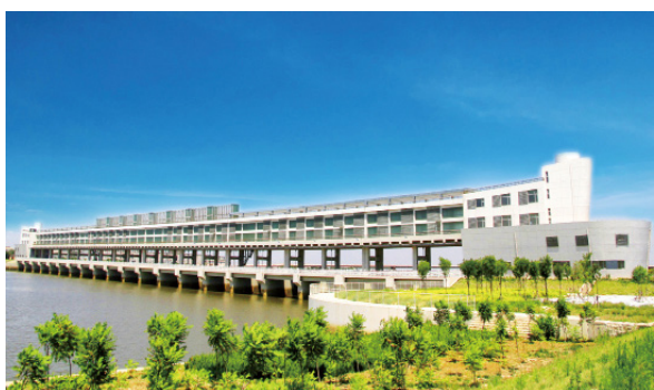
△ 永定新河治理一期工程（获得中国水利工程最高荣誉“大禹奖”。）
