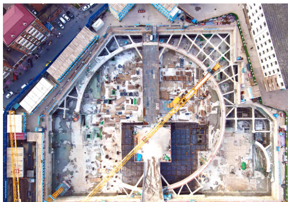
△ 深基坑变形主动控制关键技术
