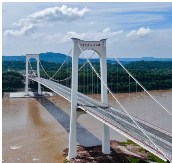
△ 重庆白沙长江大桥，是国务院《长江经济带综合立体交通走廊规划（2014—2020年）》中规划新建重点过江通道、重庆市重点基础设施和重要民生工程。
