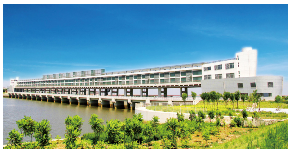
△ 永定新河治理一期工程获中国水利工程最高荣誉“大禹奖”。
