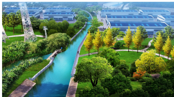
△ 广东佛山市红星运河水系水环境综合治理工程，助力粤港澳大湾区绿色低碳发展。
