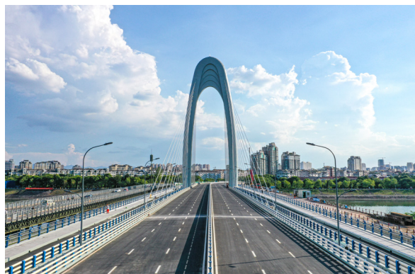
△ 浙江金华市金婺大桥，创国内桥梁钢索塔牵引竖转重量之最。
