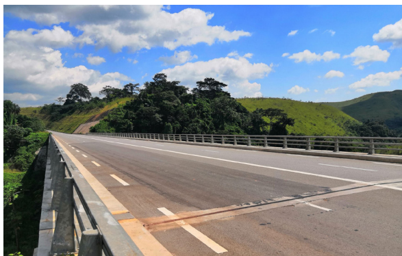
△ 刚果（布）国家一号公路钢结构桥梁项目亮相第13届国际基建论坛。
