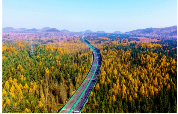
△ 鹤大高速（中建集团单次施工里程最长高速公路。）
