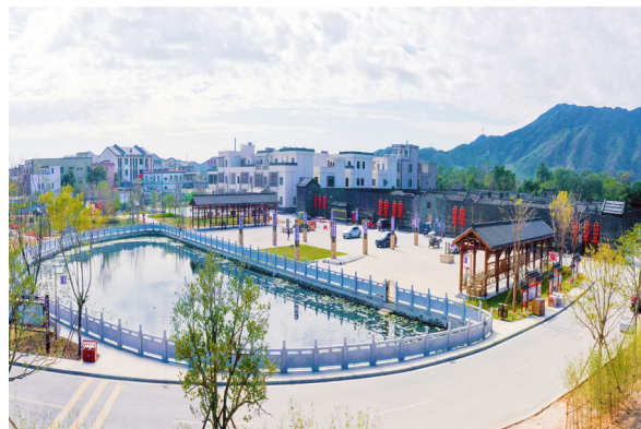
△ 华南公司承建深汕特别合作区乡村振兴项目，打造古民居文化特色村，留住历史人文乡愁。
