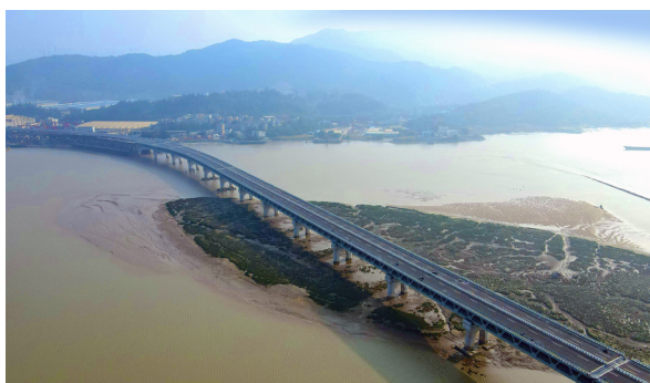
△ 福州道庆洲大桥是中国跨径最大变高度钢桁结合梁大桥和福建省首座双层公轨两用桥。
