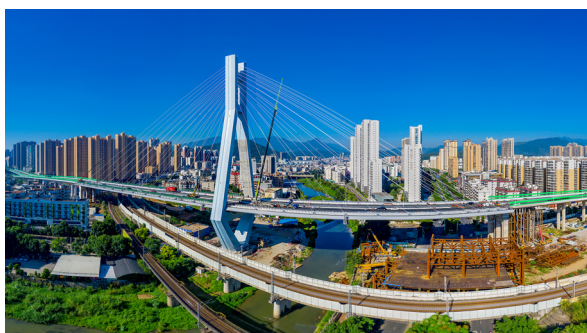
△ 福建龙岩大桥是世界首次采用水平二次转体施工的非对称独塔双索面钢箱梁斜拉桥。
