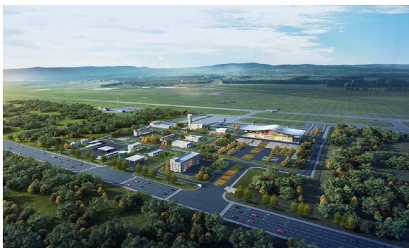
△ 四川阆中民用机场航站楼及配套设施工程目。
