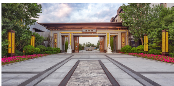
△ 中建·海纳府，中建 CI 金奖，金盘奖全国最佳软装空间，天津 2020 年度榜样楼盘，2020 天津年度地产人气宜居项目。
