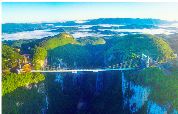
△ 张家界大峡谷玻璃桥（曾创造世界桥梁建设“十项之最”，被 CNN 评为“全球 11 座新建最壮观大桥”之一，获得世界桥梁领域最高荣誉“亚瑟·海顿奖”、国家优质工程奖、华夏建设科技奖等荣誉。）
