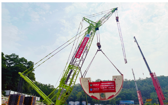
△ 中建六局首台大直径盾构机“六局 10 号”在深惠城际 2 标三工区项目顺利下井。
