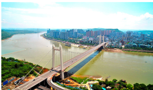
△ 重庆几江长江大桥（曾创两项“第一”，北岸隧道锚碇塞体国内最长、南岸重力式锚碇西南最大，获得中国土木工程詹天佑奖、国家优质工程奖等荣誉。）
