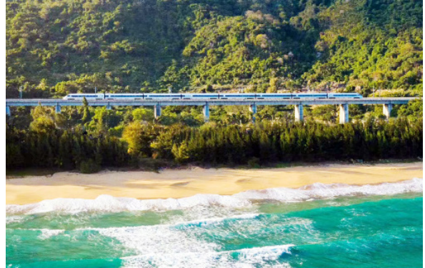
△ 海南西环铁路（全球首条环海岛高速铁路。）
