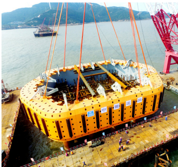
△ 复杂海域环境下大型跨海桥梁施工关键技术
