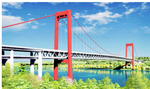
△ 四川泸州长江二桥（四川省泸州市第一座跨长江悬索桥，泸州市第一座双层公轨两用长江大桥。）
