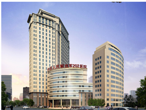
△ 中国人民解放军二〇二医院门急诊综合楼新建工程，获得国家优质工程奖。
