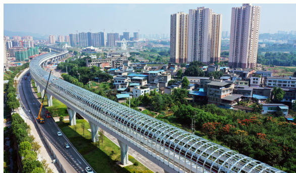
△ 重庆轨道交通5号线跳磴至江津段，是国内首条商用“双流制”市域（郊）铁路。
