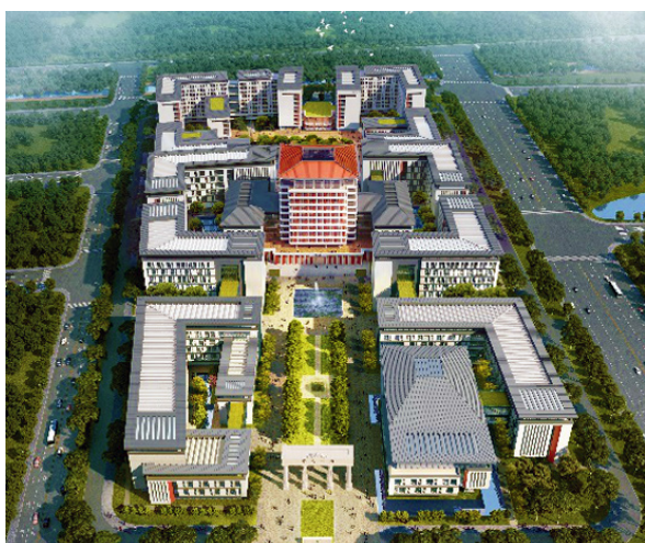
△ 广州大学黄埔研究院项目，助力打造粤港澳大湾区新一代信息技术、人工智能与区块链等高精尖产业集群及技术创新策源地和人才高地。
