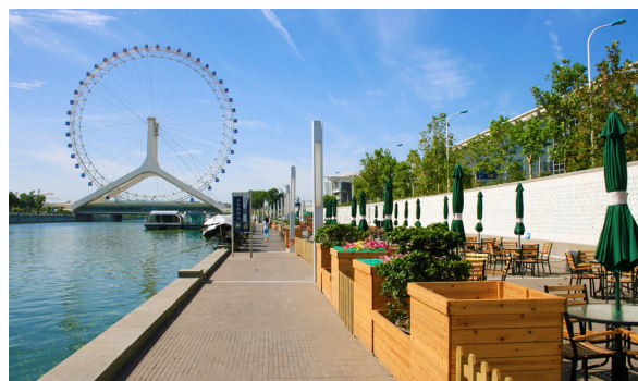
△ 天津海河堤岸综合整治工程（海河两岸综合开发工程的十大基础工程之一，构筑与天津国际化大都市形象相适应的“水清、岸绿、景美、游畅”的滨河景观。）
