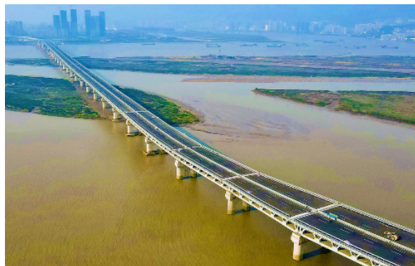
△ 福建道庆洲大桥（国内跨径最大钢桁结合连续梁桥，国内首创双层变高度钢桁结合梁桥。）
