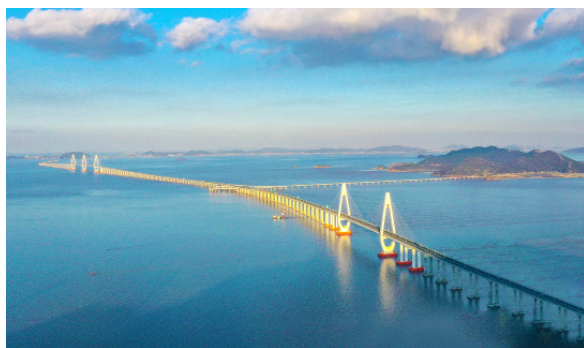
△ 浙江舟岱跨海大桥（世界最长连岛高速，世界规模最大跨海桥梁群，中建集团建设的首座深海大桥。）
