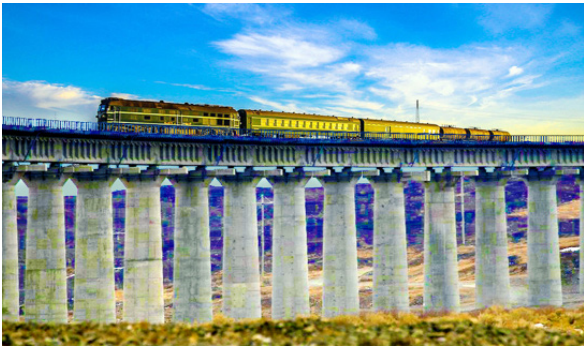
△ 额哈铁路（中建集团首个超过一百公里的铁路项目。）
