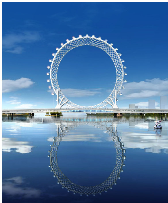
△ 山东潍坊白浪河大桥摩天轮，获得CTBUH全球奖最佳高层非建筑奖、中国钢结构金奖等多项荣誉。
