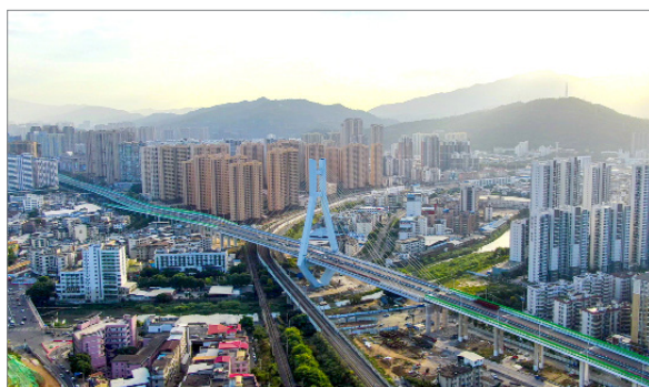
△ 福建龙岩大桥（世界首次采用水平二次转体施工的非对称独塔双索面钢箱梁斜拉桥，创造了最大转体重量、最大转体悬臂、最大转体梁宽、最大倾斜角度下塔柱 4 项世界纪录。）
