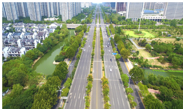
△ 合肥徽州大道项目斩获中国建设工程鲁班奖。
