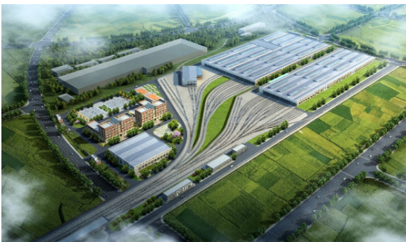
△ 天津地铁7号线（天津首条PPP模式整线地铁项目。）
