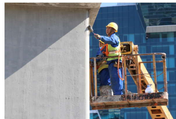
盖梁施工现场
