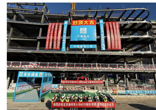
项目钢结构封顶
