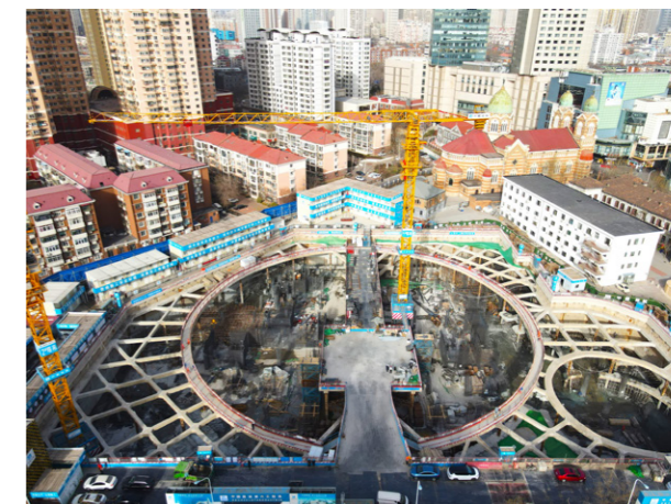
天津市中心妇产科医院改扩建工程项目 建设过程实景图
