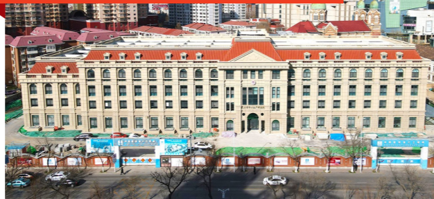
天津市中心妇产科医院原址改扩建工程
