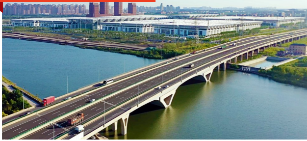
蓟汕高速公路海河特大桥
