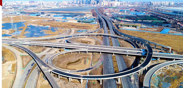
天津滨海新区西中环快速路海河以南段一期
