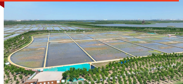
天津市津南区再生水利用及水生态综合修复工程
