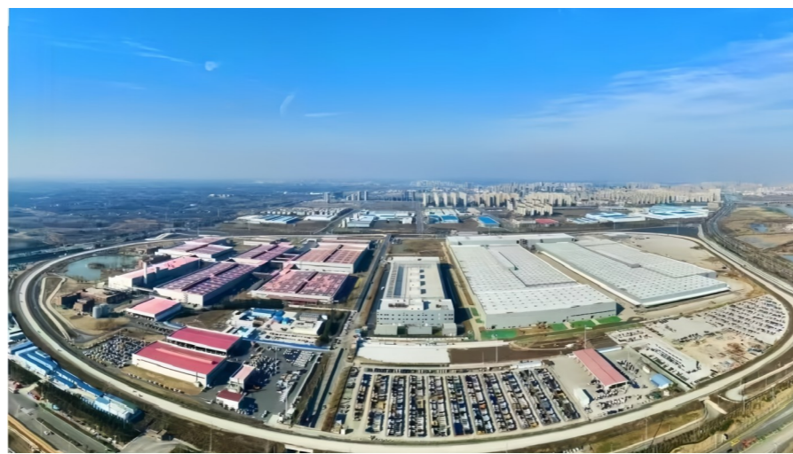
安徽肥西新能源汽车产业园EPC项目
