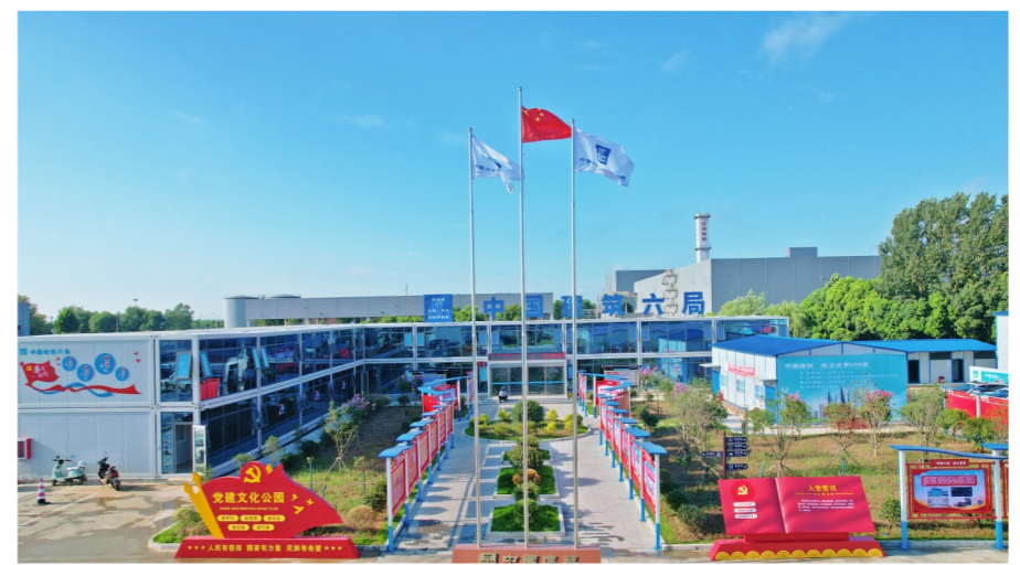
项目红色工地·党建文化公园
