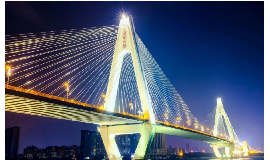
海口世纪大桥。
